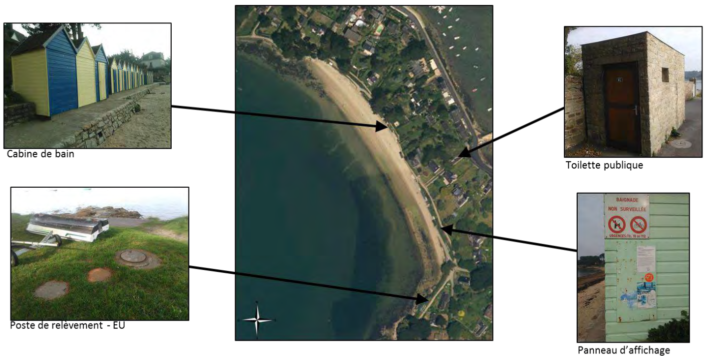
Figure 15 : équipements de la plage du Dréhen
