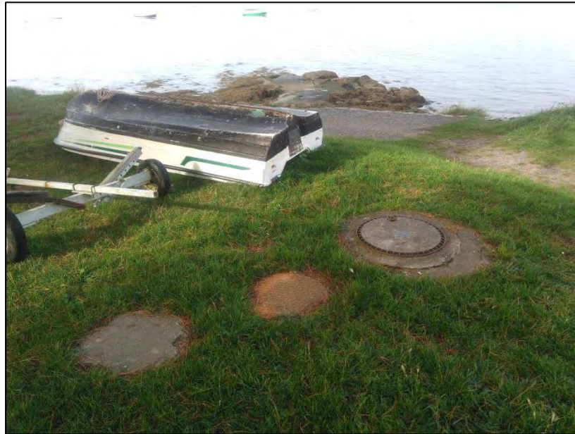
Figure 29 : poste de relèvement de la Corniche
