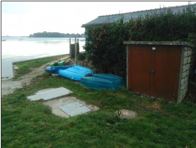
Figure 30 : poste de relèvement de Port Miquel
